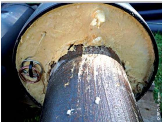
Изолированные трубы оснащены системой технического контроля. В теплоизоляцию трубы закладываются два медных провода, которые осуществляют контроль посредством измерения сопротивления и срока действия и используются в случае повреждения или утечки.
