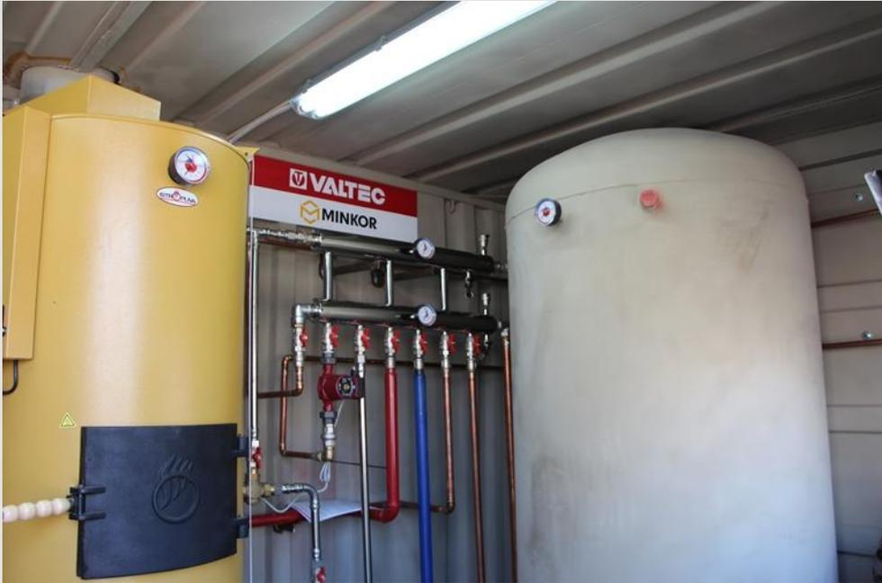
3. За счет специально разработанной обвязки котлов в котельной можно опускать температуру выходного теплоносителя до необходимой, например, до 40 °С. Тем самым, происходит **ЭКОНОМИЯ ТОПЛИВА** и нет лишней потери тепловой энергии.
