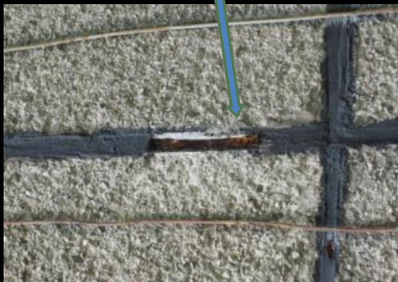
Руйнування панельних стиків
