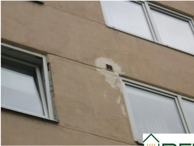
Before renovation До реновації
