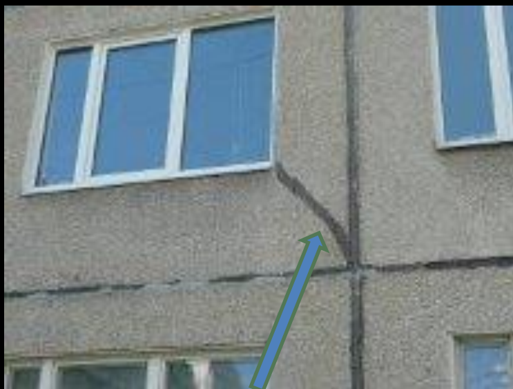
Руйнування панельних стиків
