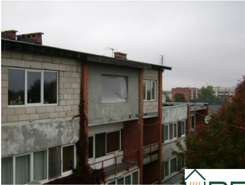
Before renovation До реновації
