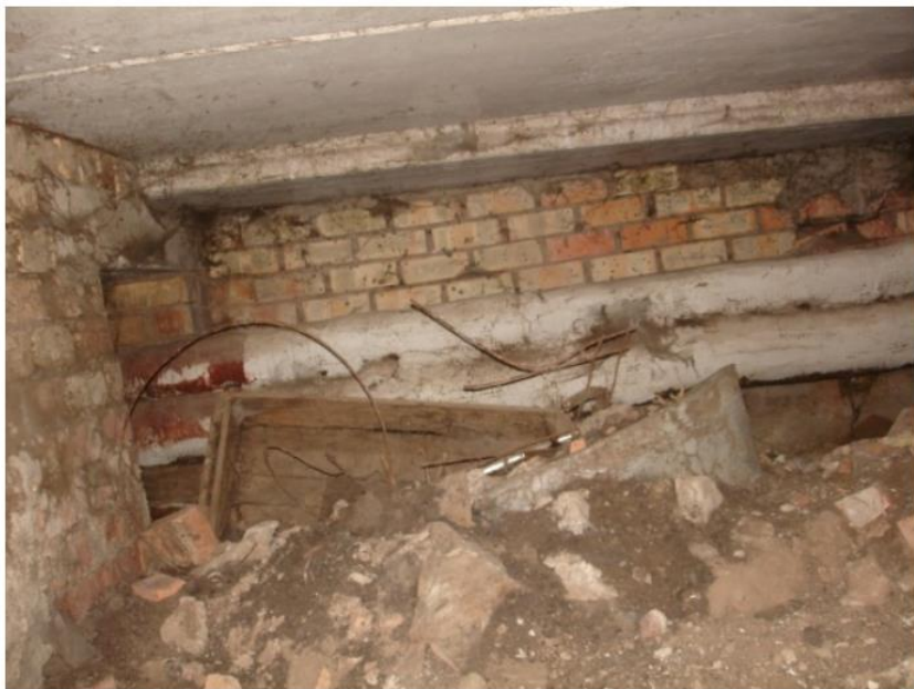
Before renovation До реновації
