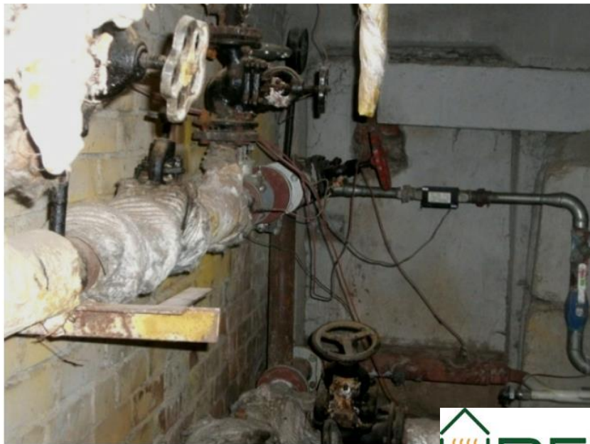
Before renovation До реновації
