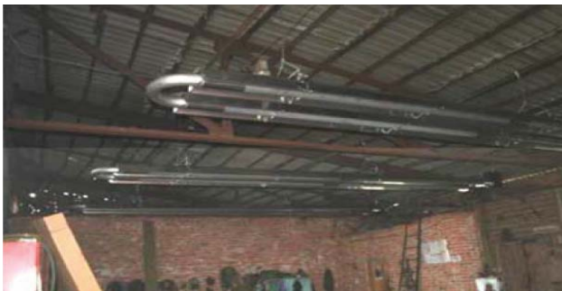
Рис. 5.26 Інфрачервоні нагрівачі на полігоні у м. Хмельницький, Україна
