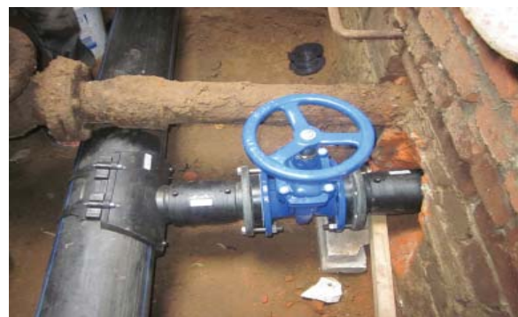
Рис. 2.5 Монтаж поліетиленових трубопроводів та арматури
