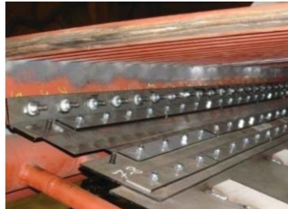
Рис. 1.16 – Пристрій для запобігання просипу на вібраційній решітці котла BWE
