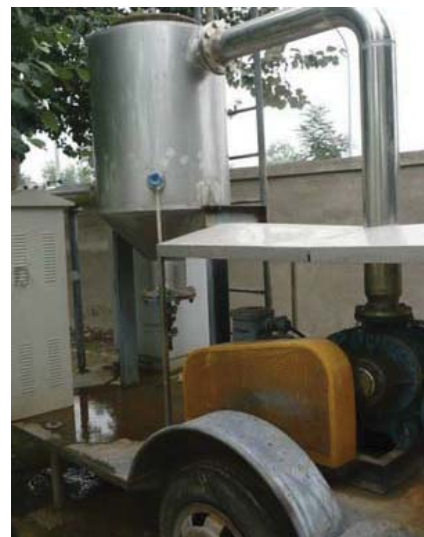
Рис. 5.22 Відведення конденсату перед факелом на полігоні Gaoantun, Китай
