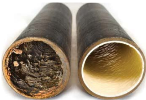
Рис. 2.6 Санація старого металевого трубопроводу
