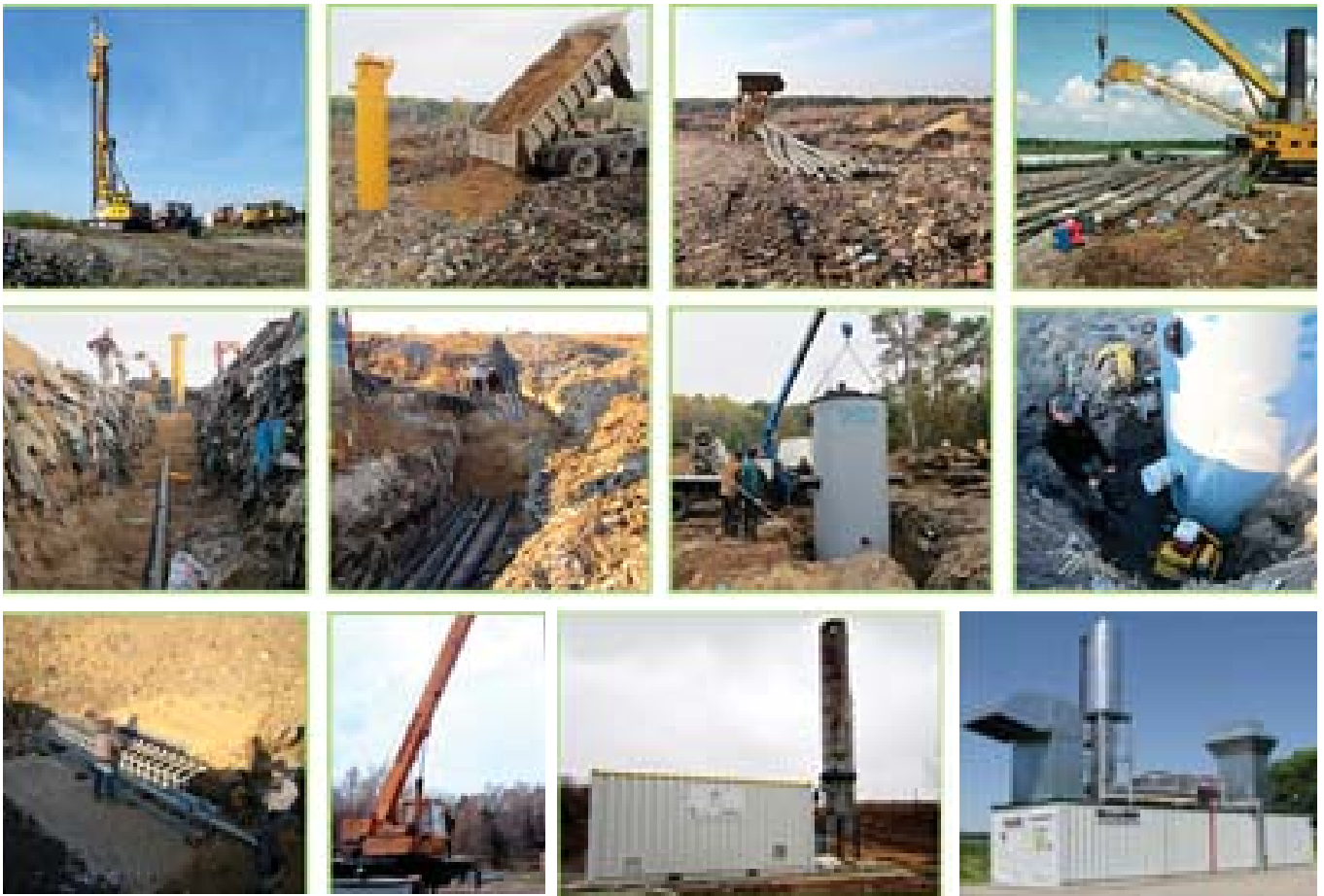
Рис. 5.21 Основні етапи виконання робіт по будівництву системи збору та утилізації ЗГ
