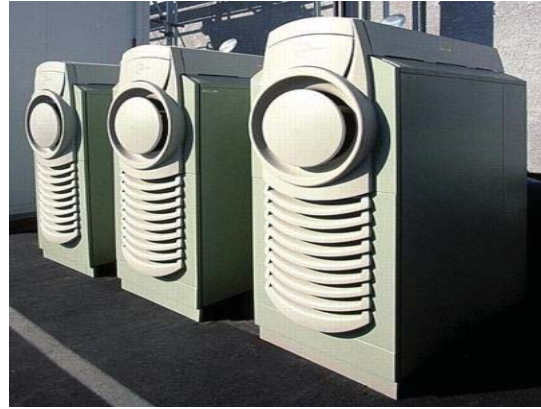
Рис. 5.31 Когенераційна мікротурбіна компанії Capstone в школі штату Іллінойс, США
