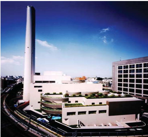
Рис. 5.11 Сміттєспалювальний завод, район Шібуя в Токіо,
