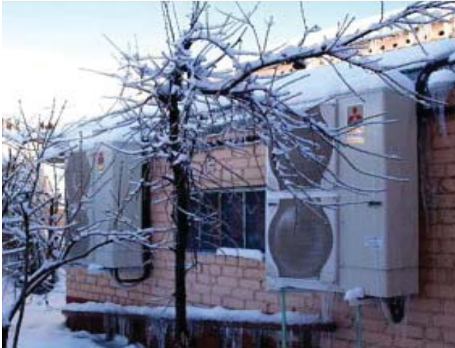
Рис. 1.39 Встановлення повітряного теплового насосу на фасаді будівлі
