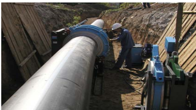
Рис. 2.5 Монтаж поліетиленових трубопроводів та арматури
